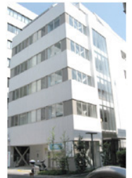
東京都助産師会館ビル
